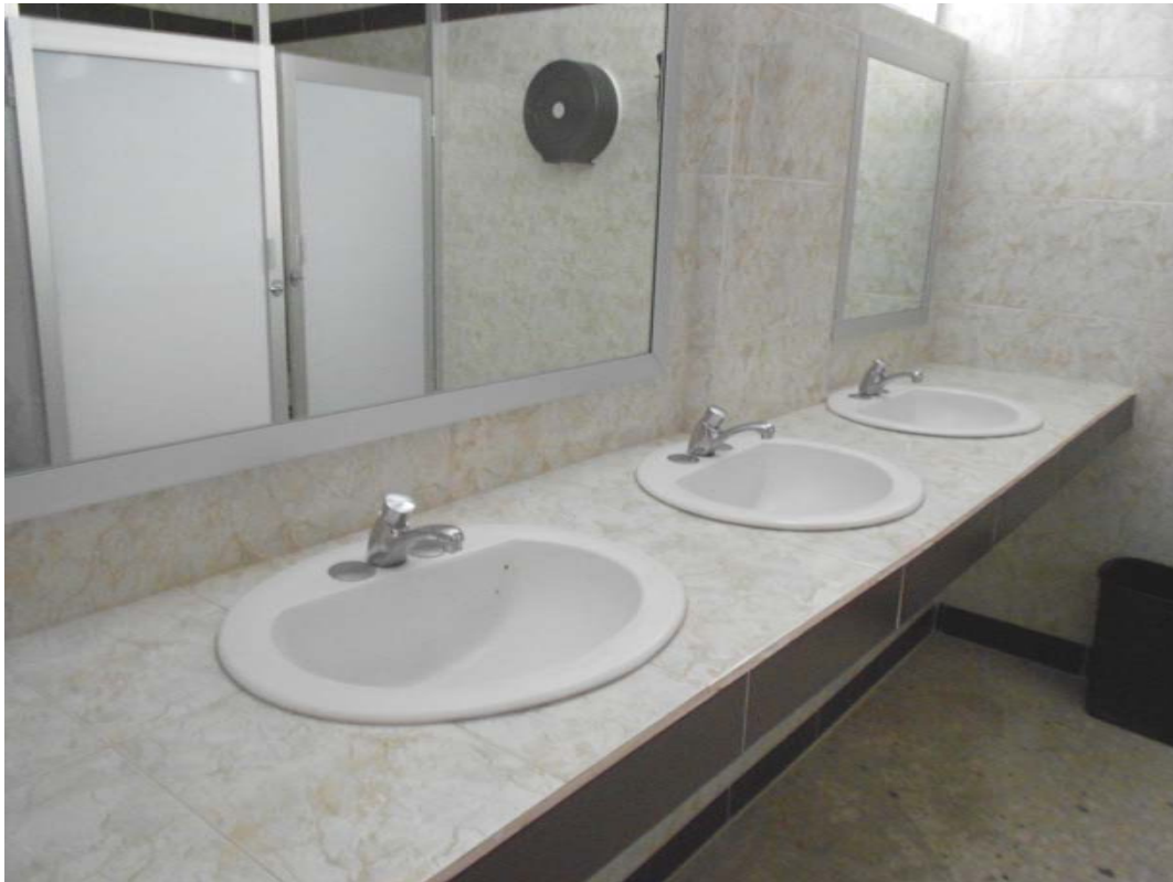
El programa de mantenimiento incluye remodelación de baños.
